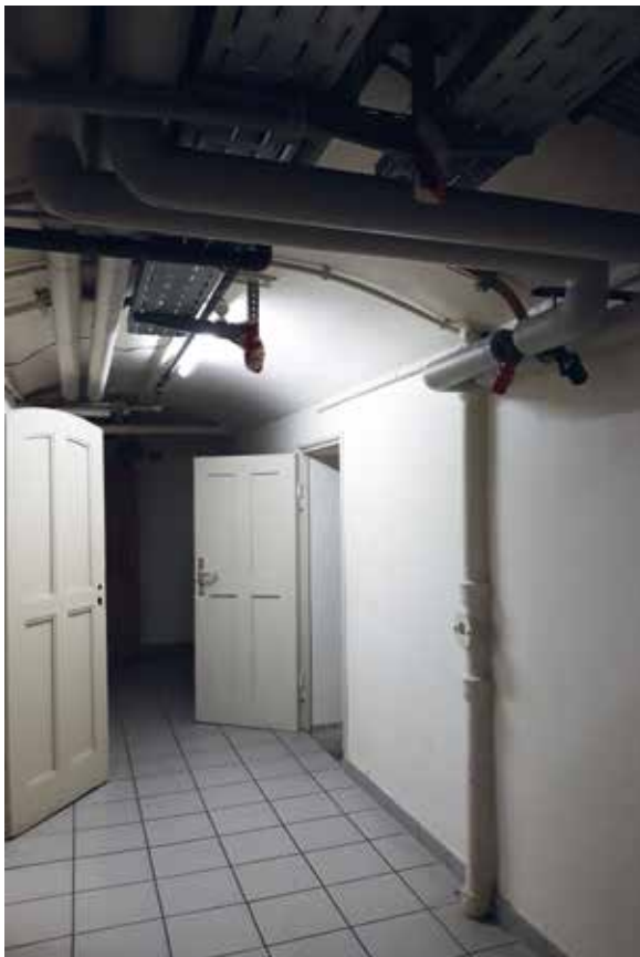
Flur vor den zukünftigen Gruppenarbeitsräumen
